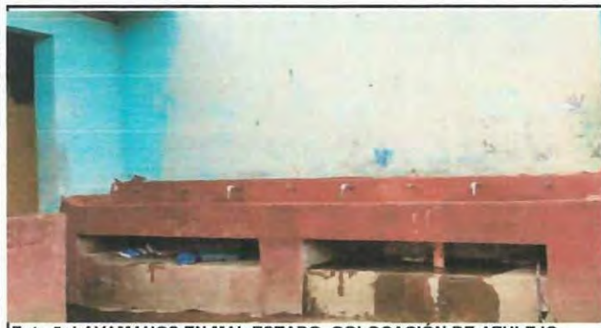
Foto 5: LAVAMANOS EN MAL ESTADO, COLOCACIÓN DE AZULEJO
